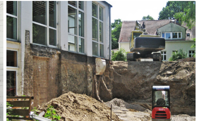
Die Baustelle im Juli 2017
